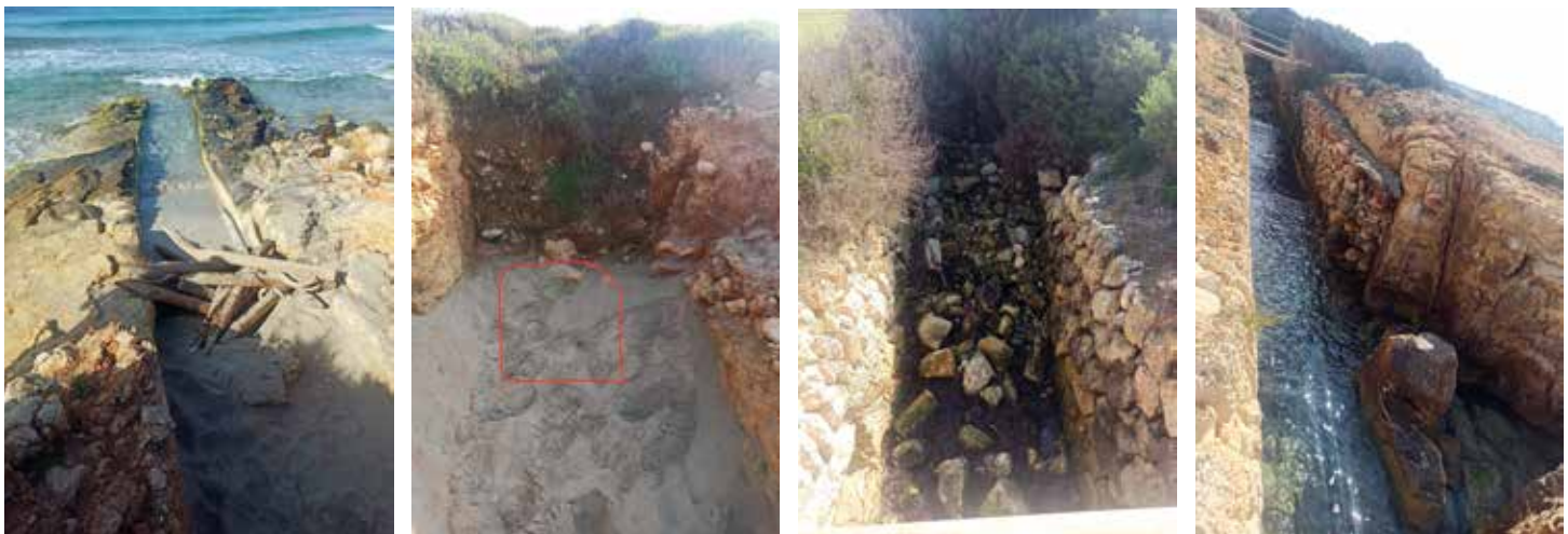
Mina vella. Esquerra: boca sortida i desguàs a mar. Dreta: túnel tapat; en vermell, contorn aproximat de la boca de la mina Mina nova: col·lapse i sortida al mar
